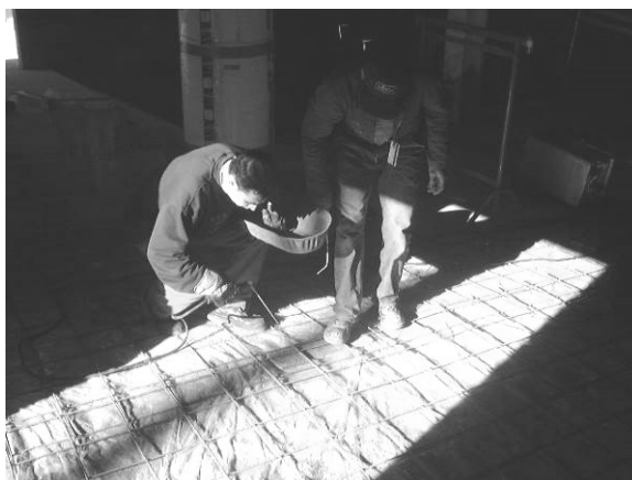
Figure 2 : Soudage du treillis
